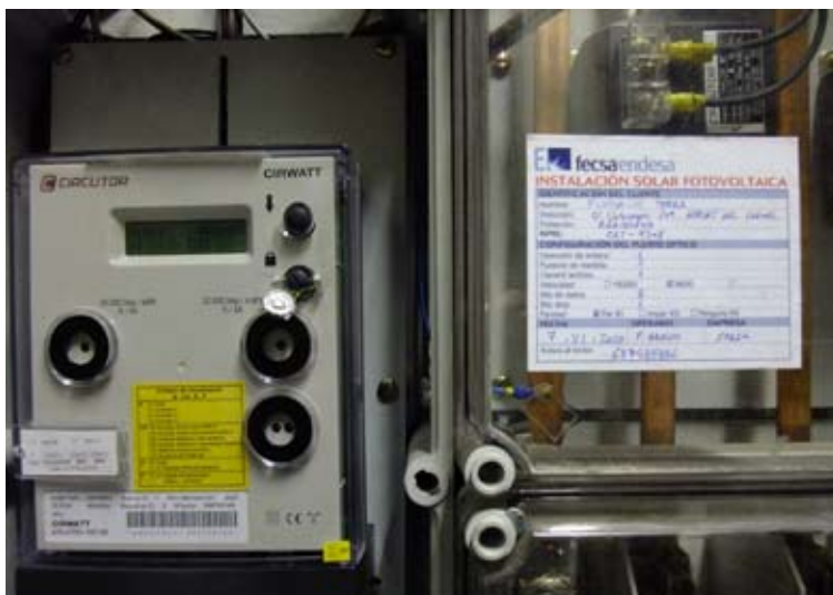
Contador de la ola solar del mercat del Carmel en Barcelona, instalació fotovoltaica participada popularmente.
