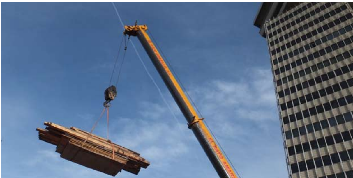
Una grua de gran tonaje retira las maderas residuales que fueron la tarima de los domos geodésicos.
